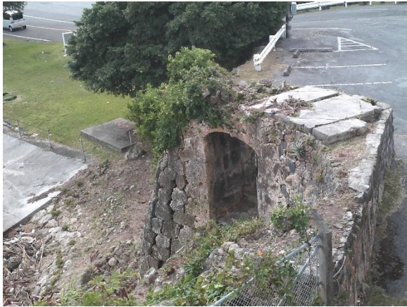
写真7 アーチ門上部のコンクリート板
