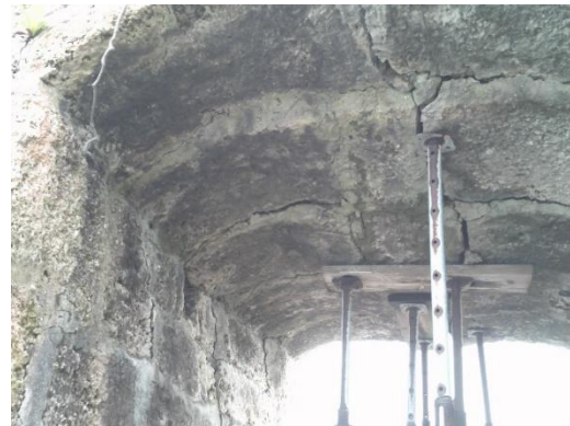
写真6 アーチ門の内部
