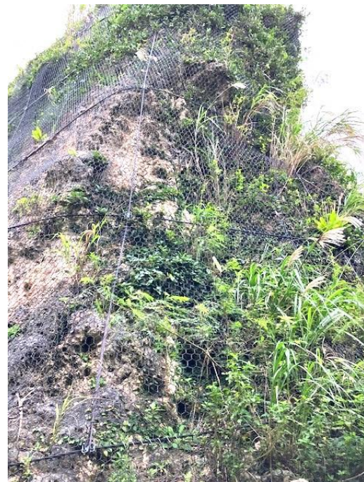
写真10 ネットで覆うワカリジー 2022年11月16日
