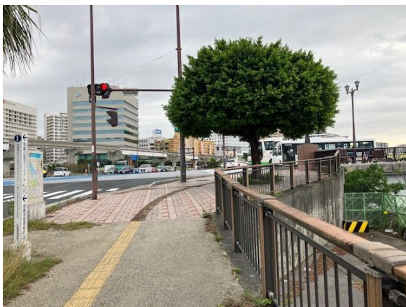
写真12 明治橋周辺 2022年11月16日
