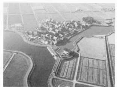
排水機場上空より(輪中内の汚水を河川に排出する)
